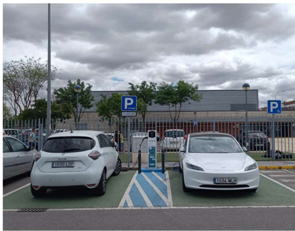
6. COCHES ELÉCTRICOS CARGANDO RN LA ZONA DE APARCAMIENTO (PISCINA CUBIERTA)
