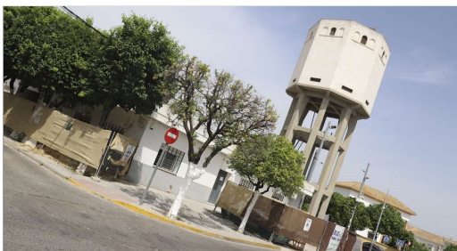
Las obras en Servicio Sociales se extenderán hasta el último trimestre del año.
