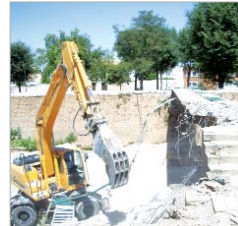
Derrumbe del puente en agosto.
