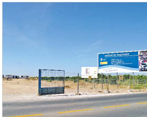
Estado del terreno que se está acondicionando para ubicar la Central.
