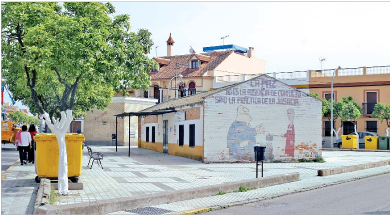
La plaza de San Juan Bosco será una de las que se rehabilitarán.
