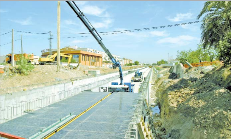
Estado en el que se encuentran las obras del arroyo a su paso por el puente del Malecón.
