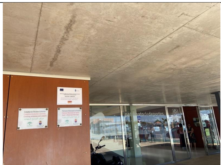
PLACA COMUNICACIÓN ENTRADA EDIFICIO
